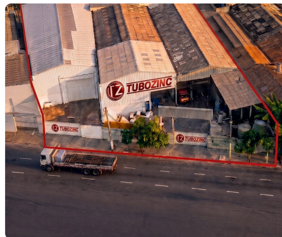
Unidade da Tubozinc em Diadema — São Paulo.
